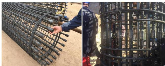
Fig.3: visión general de los acopladores en una estaca.
